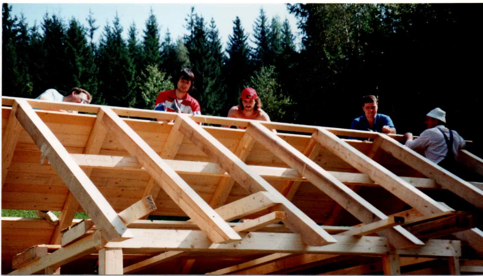
Viele fachkundige Hände zauberten den Rohbau hin.
