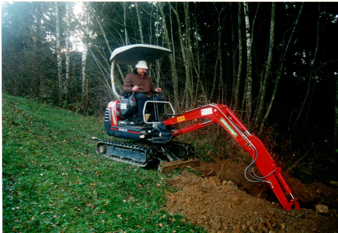
Gelernt ist gelernt: Wolfi beim abenteuerlichen Baggermanöver auf dem Steilhang.
